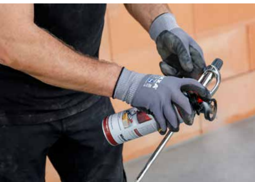
6. En cas de pauses plus longues, retirez la bombe Dryfix extra et nettoyez la tête de projection avec Dryfix cleaner
