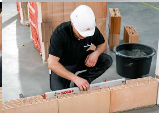
7. Contrôlez la planéité dans le sens longitudinal sur 3 blocs (longueur du niveau \geq 80 cm)
