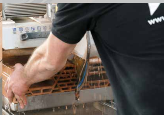
18. Découpez les blocs au moyen d'une scie à table
