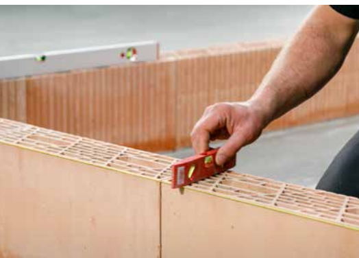
6. Contrôlez la planéité de l'assemblage à tenons et mortaises
