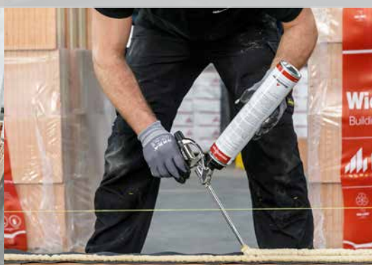
12. Appliquez 2 cordons de Dryfix extra sur la barrière anti-humidité
