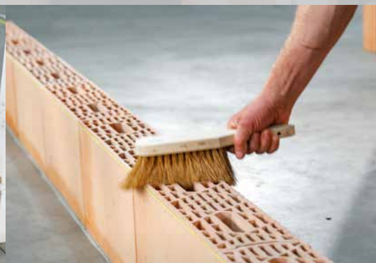
8. Brossez les blocs (répétez l'opération pour l'application de chaque couche)
