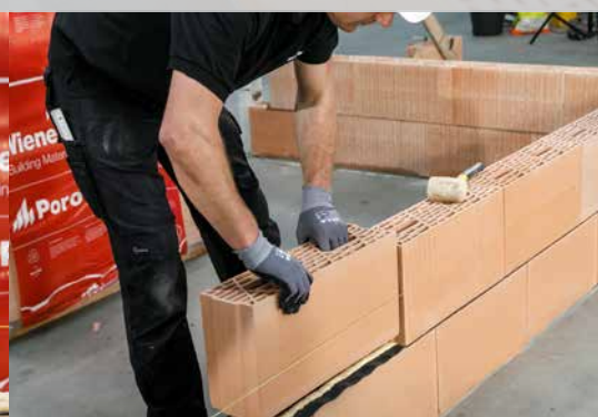
13. Posez la seconde couche de blocs
