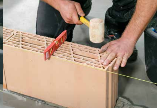
5. Contrôlez la planéité perpendiculairement au mur
