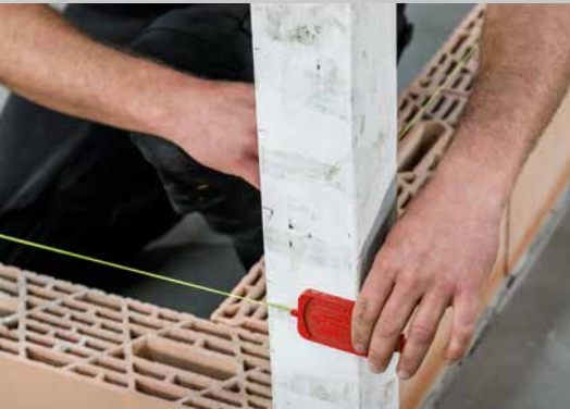
9. Appliquez le cordeau de maçon à une hauteur de \pm 2 cm sous la hauteur de la seconde couche
