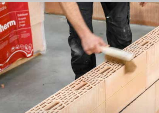
14. Brossez les blocs
