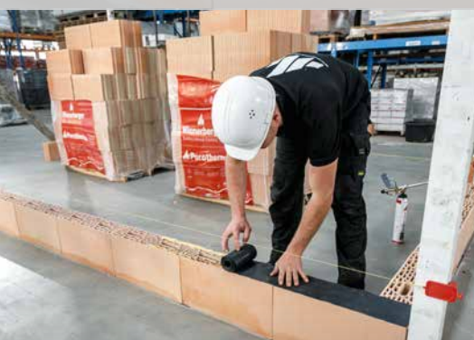
11. Placez la membrane d'étanchéité et compressez celle-ci correctement sur la mousse Dryfix extra appliquée
