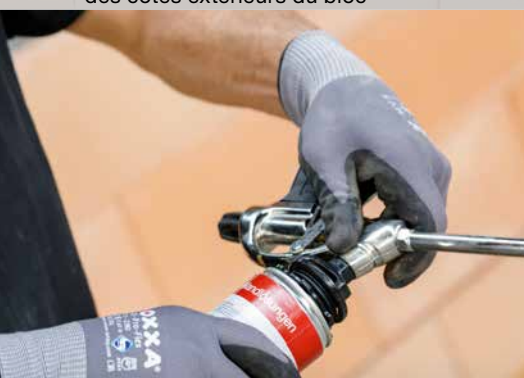
3. Vissez la bombe Dryfix extra sur la tête de projection nettoyée
