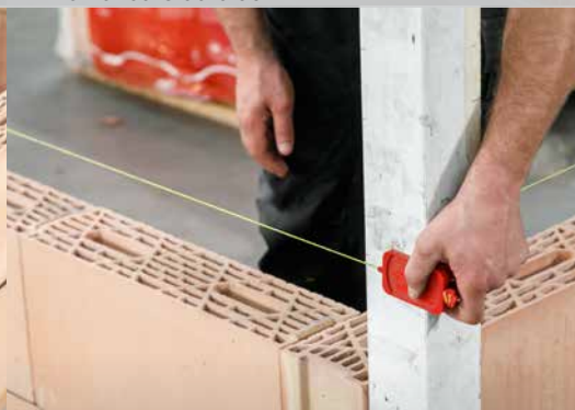
15. Appliquez le cordeau de maçon à une hauteur de \pm 2 cm sous la hauteur de la couche suivante
