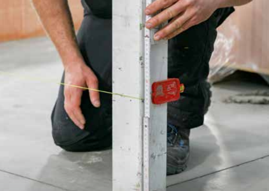
3. Placez le cordeau de maçon pour la première couche de blocs
